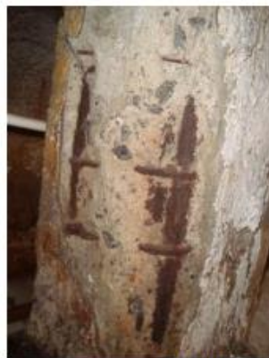
Figura 19: Pilar com armadura aparente.
