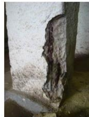
Figura 19: Pilar com armadura aparente.
