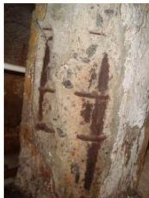
Figura 19: Pilar com armadura aparente.
