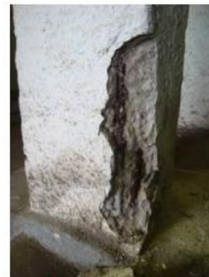
Figura 19: Pilar com armadura aparente.
