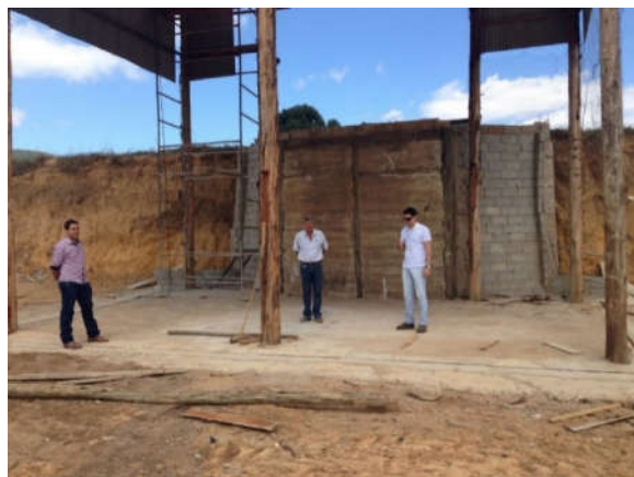
Figura 3-26 - Estação de Transbordo em reforma.
