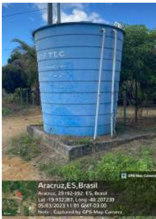
Figura 6-7: Reservatório apoiado da comunidade de Lajinha
