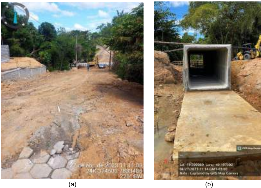
Figura 9-33: Reconstrução do bueiro no Córrego São José.
