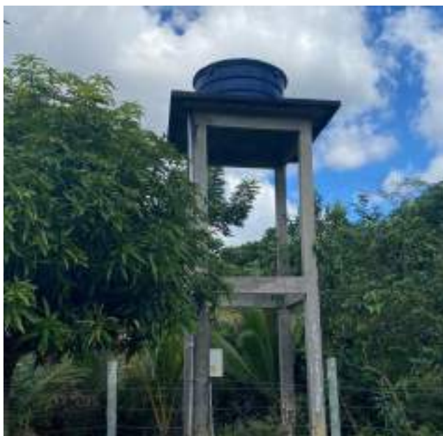
Figura 6-8: Reservatório elevado da comunidade de Lajinha
