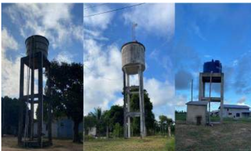
Figura 6-12: Reservatórios de água, Aldeia Pau Brasil.
