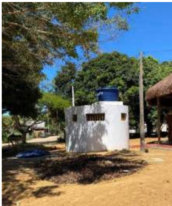
Figura 7-4: Banheiro com fossa, Aldeia Irajá.
