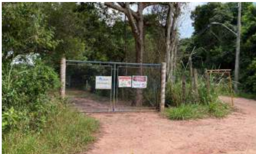
Figura 7-2: Entrada da ETE Coqueiral, Aldeia Piraquê-Açu.
