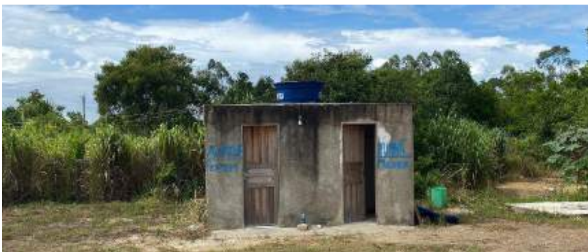
Figura 7-5: Banheiro, Aldeia Amarelos.
