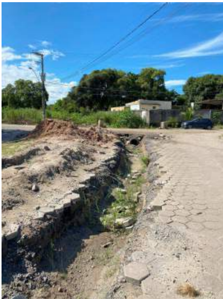
Figura 9-49: Manilha do início da canalização do córrego. Em visita em 2023 aparentava um início de obra no local.
