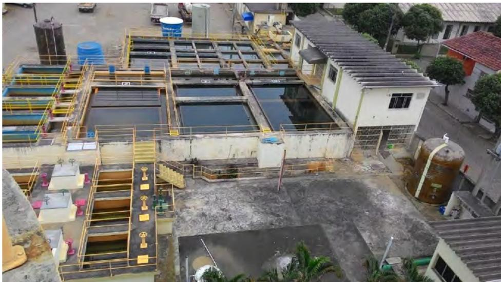
A estação foi inaugurada em 23 de junho de 1968 com capacidade de produção inicial de 100 l/s por meio de um sistema de filtração direta, possuindo os módulos de coagulação, floculação, filtração, desinfecção, correção de pH e fluoretação. Em 1991 o sistema foi ampliado para a vazão de
