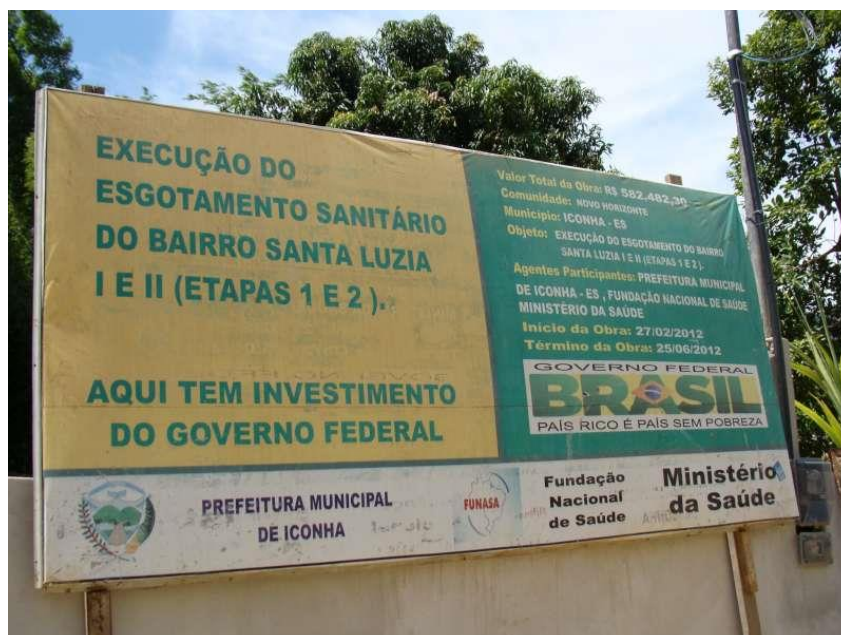
Figura 55: Placa de identificação da implantação do SES no Bairro Novo Horizonte.
