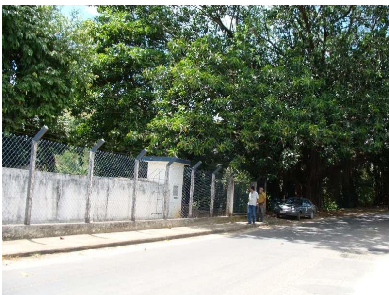
Figura 67: Proximidade da ETE de Bom Destino com a rodovia.
