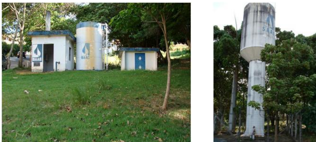
Figura 27: a) Elevatória e nascente; e b) Reservatório no alto da Morada Vale do Sol.
