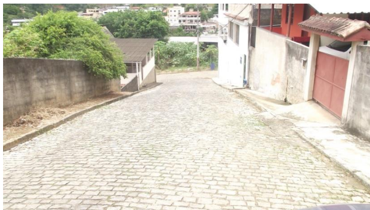
Figura 78: Bairro Jardim Da Ilha – alta declividade, sem a presença de drenagem.
