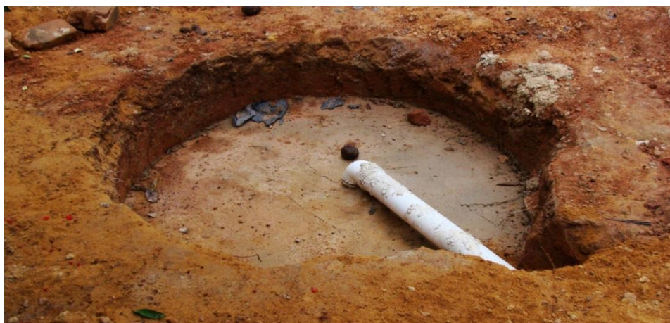
Figura 50: Fossa construída com pneus de caminhão.
