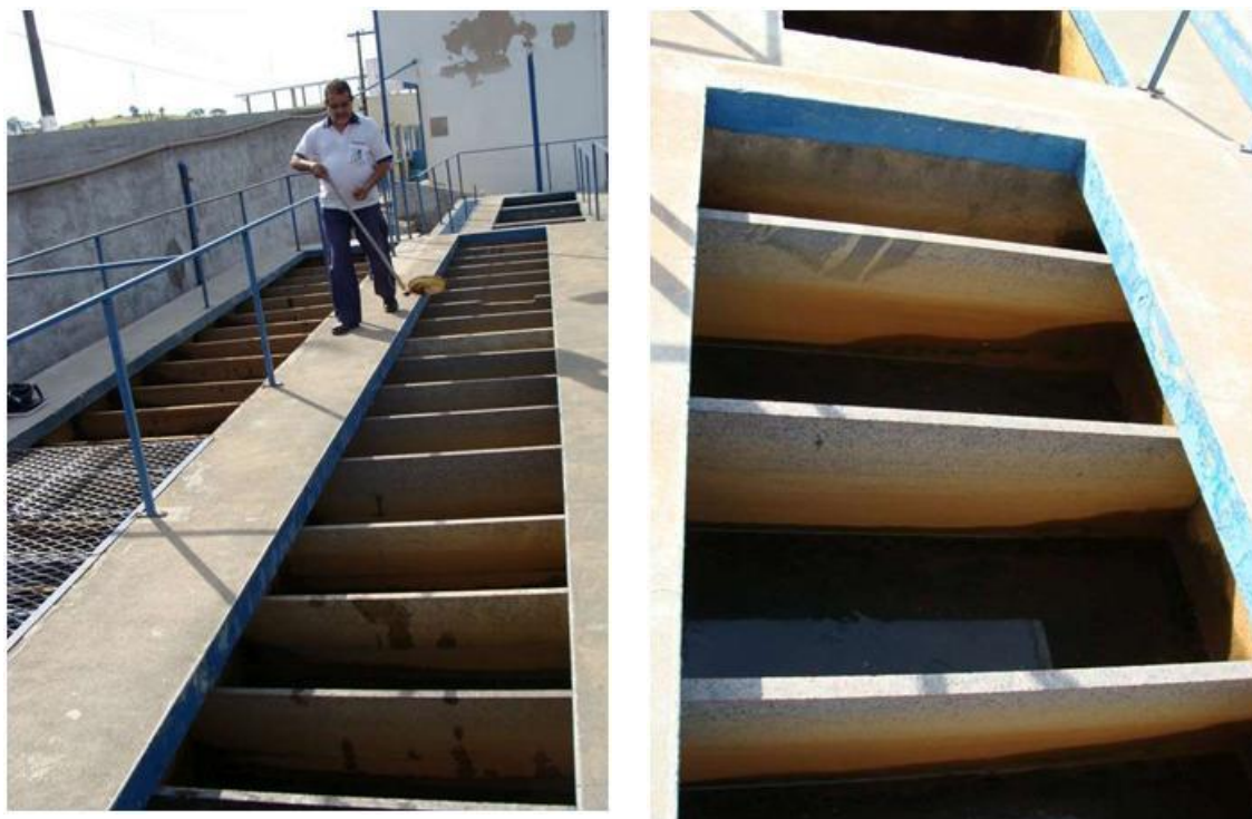
Figura 17: Floculador hidráulico da ETA de Iconha.
