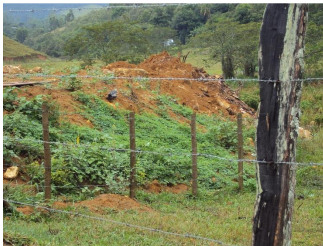
Figura 89: Área utilizada para disposição final de RCC, podas e alguns tipos de volumosos.
