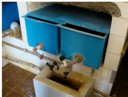
Figura 39: a) Batedores na Casa de Química; e b) Dosadores de nível constante.
