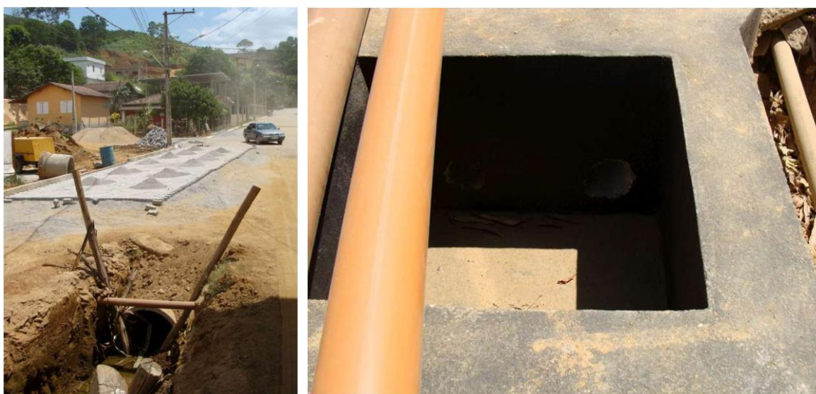
Figuras 56: a) Implantação da rede coletora; e b) Obra da ETE de Novo Horizonte.
