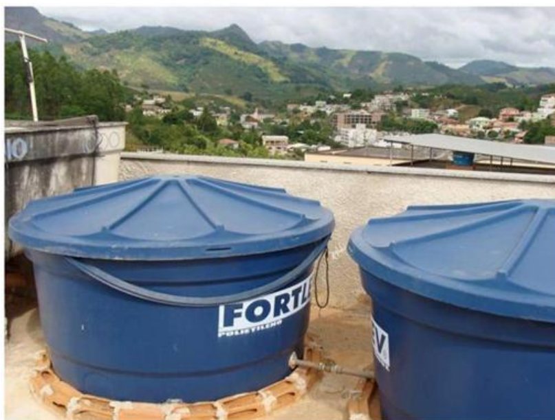
Figura 23: Armazenamento da solução de hipoclorito de sódio.
