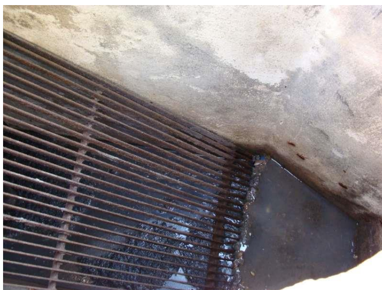
Figura 72: Pré-tratamento na ETE do Paraíso.
