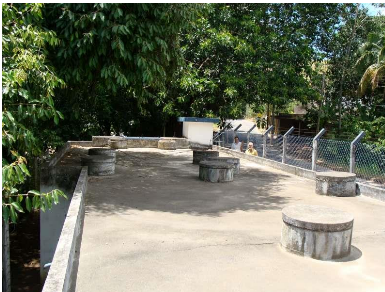
Figura 66: Laje da ETE de Bom Destino com tampas de acesso e fícus ao fundo.
