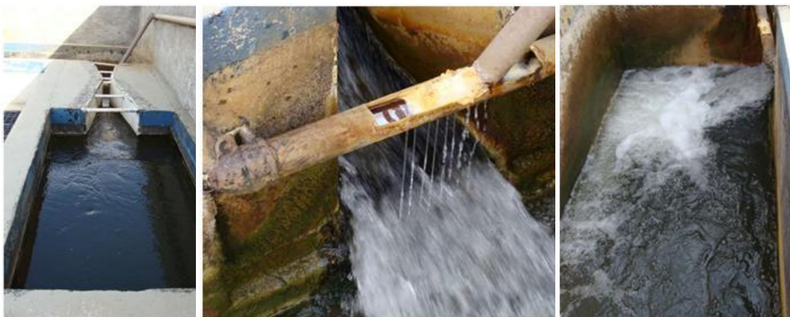
Figuras 16: a) Caixa de Tranquilização; b) Dosador de sulfato; e c) Mistura rápida.
