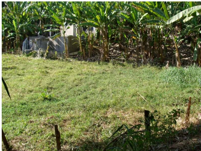
Figura 70: ETE do Bairro Paraíso entre bananeiras.
