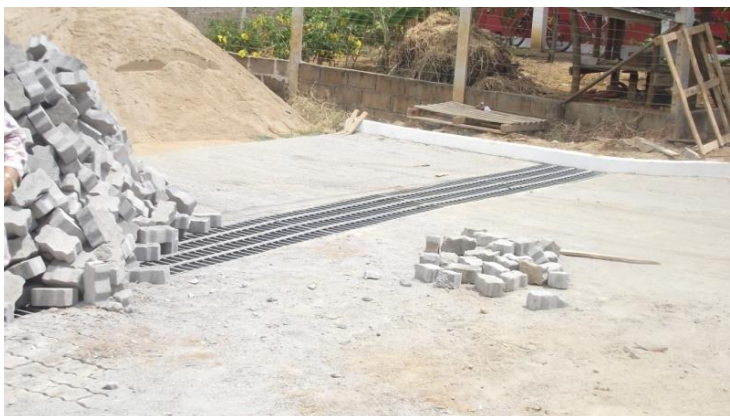
Figura 81: Bairro Novo Horizonte – obras de pavimentação e drenagem.
