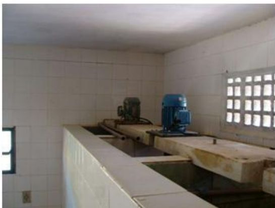
Figura 39: a) Batedores na Casa de Química; e b) Dosadores de nível constante.
