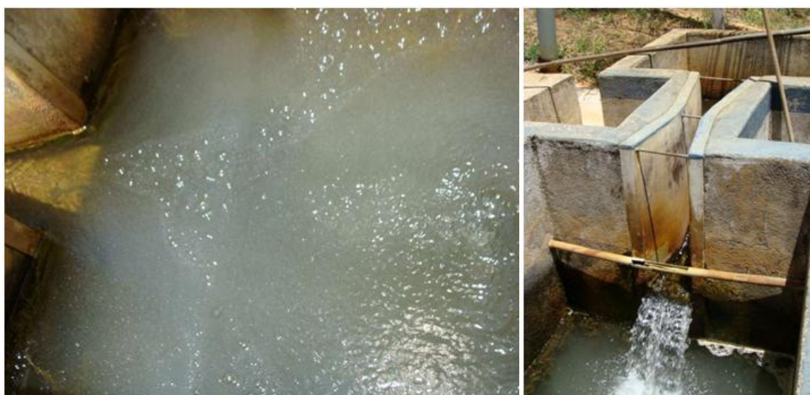
Figura 34: a) Bolhas de ar na caixa de tranquilização; e b) calha Parshall de 3 polegadas.
