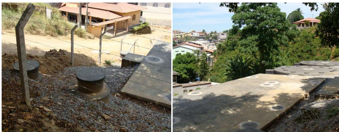
Figura 57: a) Rua com declividade acentuada; e b) ETE cercada de residências.
