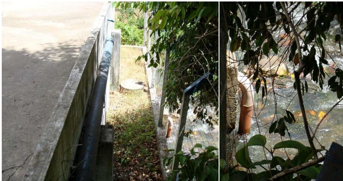
Figura 68: a) Proximidade da ETE com o rio; e b) Emissário no rio Iconha
