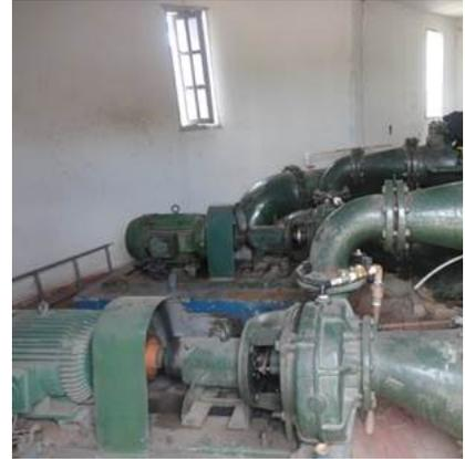
**Figura 0.3 – Bombas Utilizadas para o Recalque**
