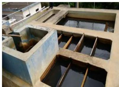
**Figura 0.44 – Vista Floculador e Decantador ETA Garrafão**
