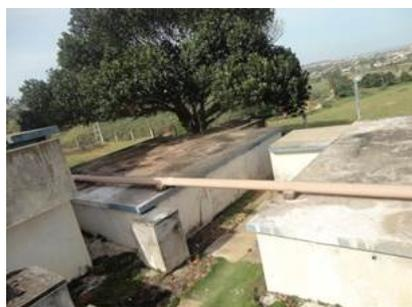
**Figura 0.22 – Tanques de Contato ETA Gomes**
