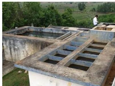
**Figura 0.39 – Vista Floculador e Decantador ETA Garrafão**
