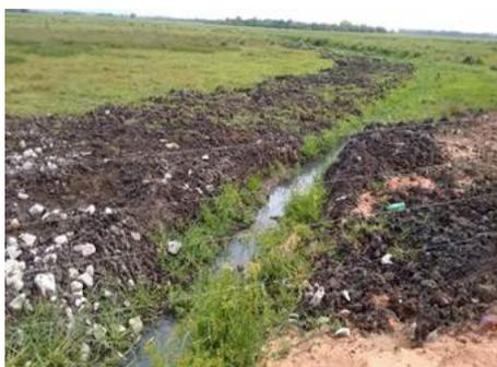
**Figura 6.10 – Saída de Rede Pluvial contaminada com Esgoto em Campo Acima**
