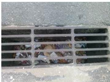
**Figura 8.1 – Falta de Manutenção Boca de Lobo**
