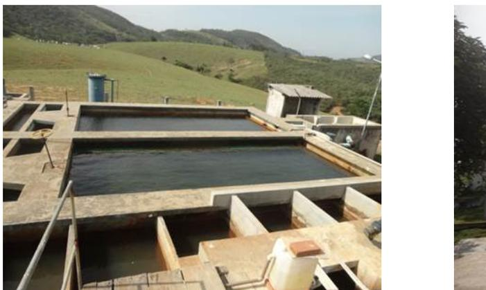
**Figura 0.18 – Vista do Floculador e Decantador da ETA Gomes**
