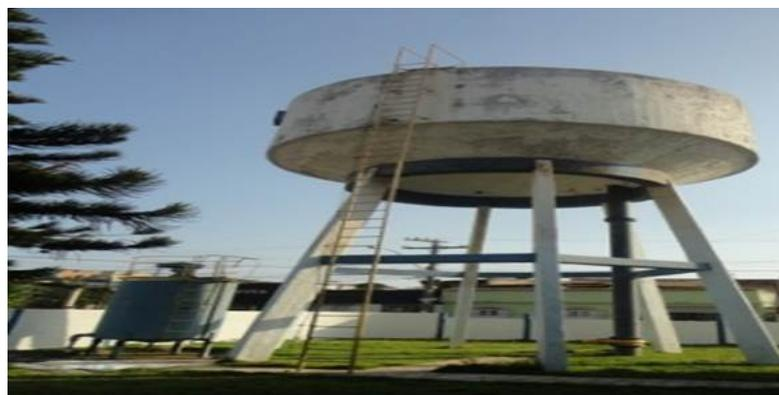
**Figura 0.9 – Reservatório para Lavagem dos Filtros**
