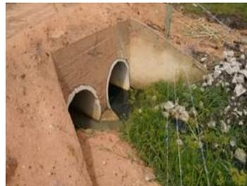
**Figura 8.8 – Manilhas de rede pluvial recebendo esgoto em Campo Acima**
