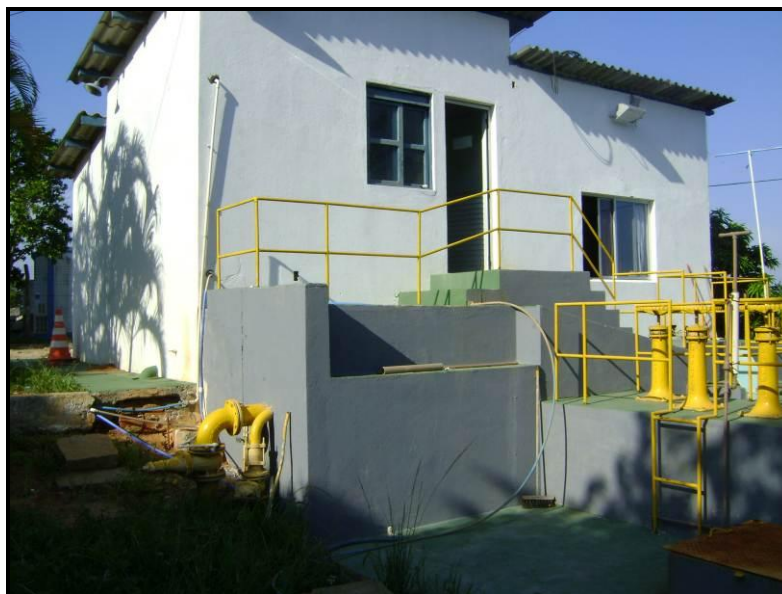
Figura 38 - Estação de tratamento de água.
