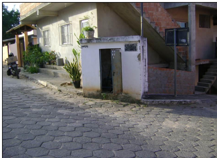
Figura 39 - Booster da Rua José Pereira Neto (Morro do Hospital).
