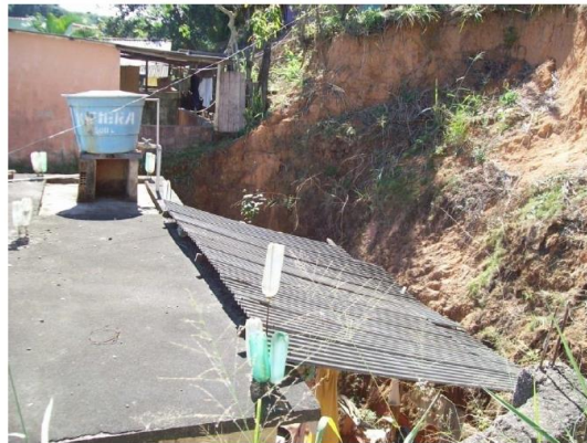
Figura 3-26 - Casas ameaçadas por outras devido ao talude mal executado. Bom Pastor, Viana-ES.
