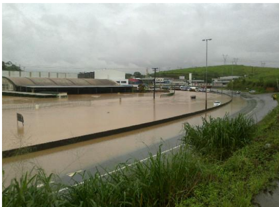
Figura 3-18 - Alagamento na BR 262, Viana-ES.
