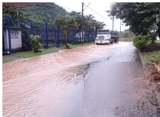
Figura 3-21 - BR 262, próximo ao bairro Ribeira, em Viana-ES.
