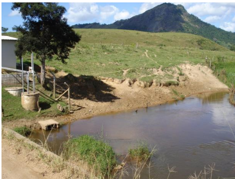
Figura 3-49 - Captação de água bruta no Rio Jacarandá.
