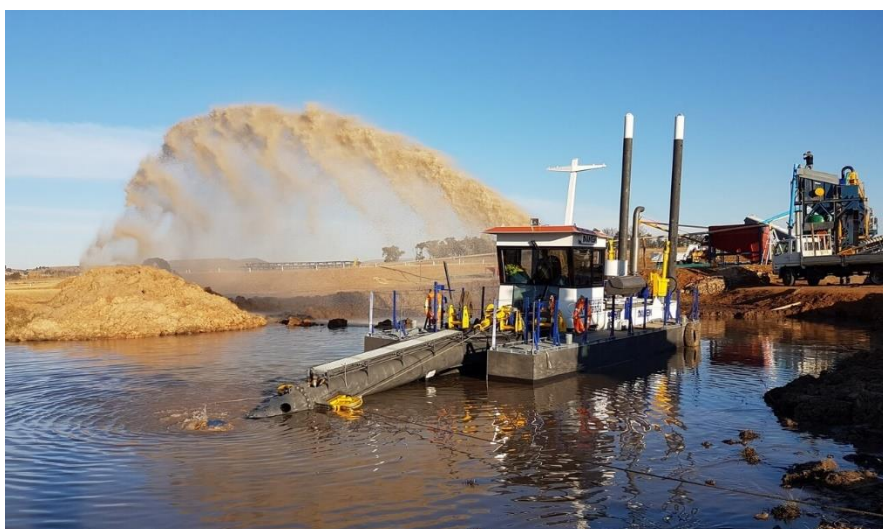
Figura 16 – Dragagem de sucção e recalque
