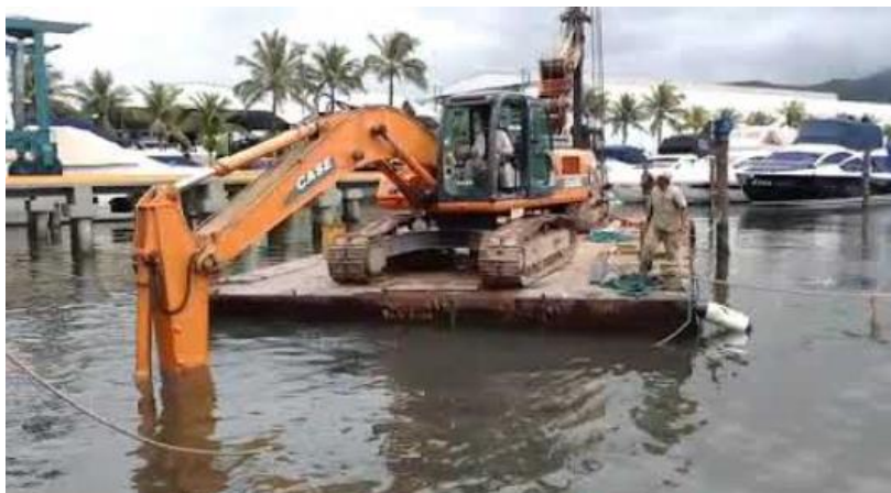
Figura 18 – Escavadeira hidráulica embarcada
