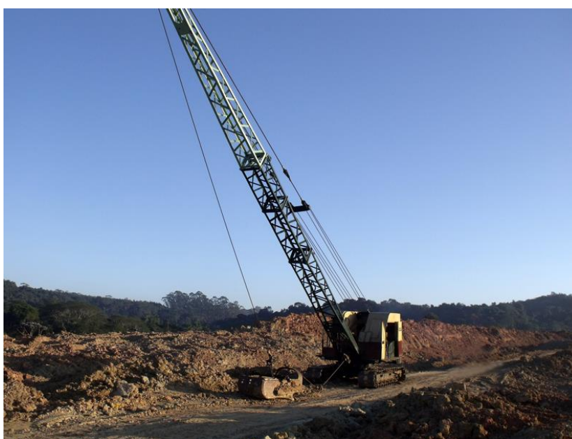
Figura 17 – Escavadeira mecânica tipo drag-line Fonte: (LF Ambiental, 2021).
