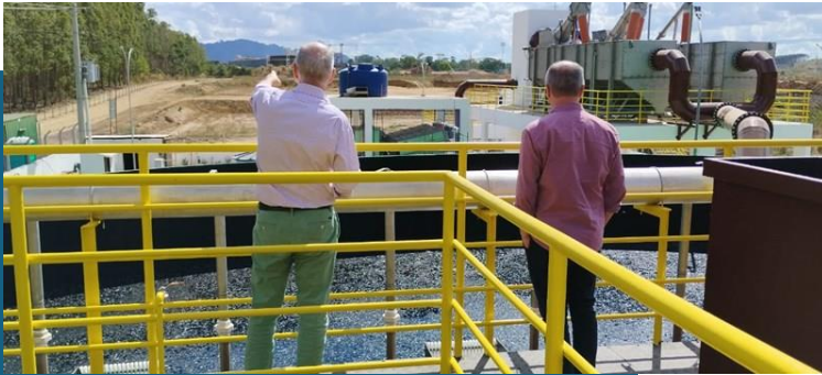
Figura 19 – ETE Sede Aracruz – visita às obras
